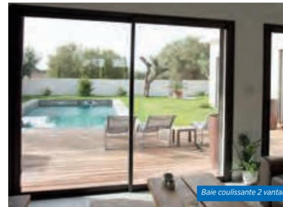
La **dilatation des menuiseries est un phénomène naturel**, on la constate de façon plus régulière sur les **baies coulissantes**. Il apparaît lors d'une exposition prolongée au soleil et déforme les profils aluminium de façon temporaire, jusqu'à disparaître dès que les températures retrouvent leur niveau habituel.
