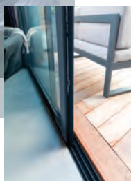
Seuil avec encastrement total intérieur et extérieur
